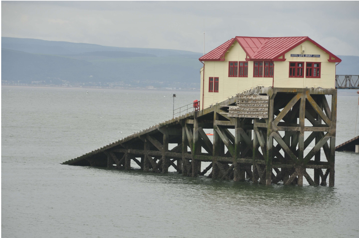
a. Mumbles Pier
